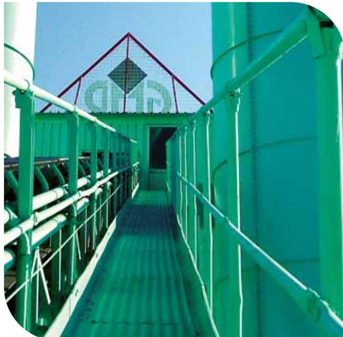
Il confezionamento del calcestruzzo viene eseguito da un impianto di produzione che, con tre punte di carico e una **capacità di 120 mc/ora**, utilizza le migliori tecniche di automazione in grado di produrre ogni tipo di calcestruzzo, garantendo velocità di carico, omogeneità nella produzione, controllo costante della qualità e tracciabilità del materiale prodotto e consegnato.
